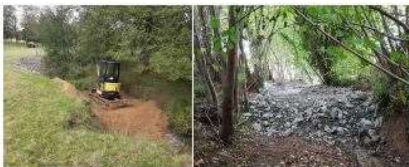
Terrassement des matériaux dans le lit
