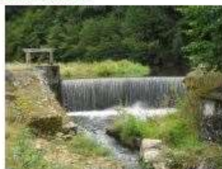
Forge du Buisson (H = 2,26 m ; H chute = 1,15 m)
