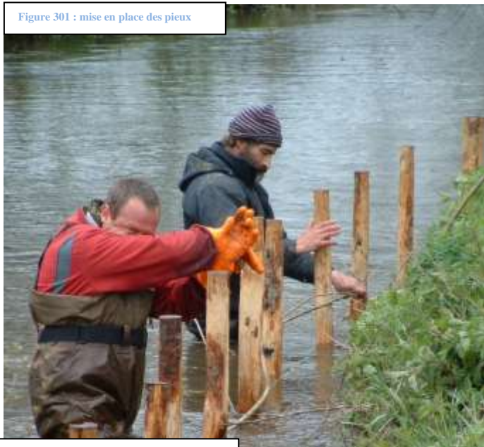
Figure 304 : réalisation du tressage-fascine
