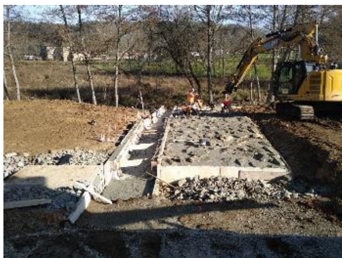
Figure 12: Création de la prise d'eau de l'étang du Chambon
