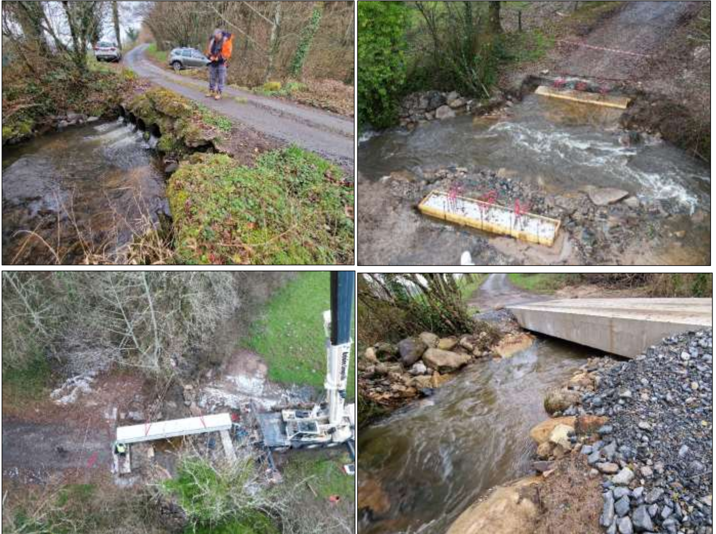
Figure 50: remplacement du pont de "Luffier" sur le Logeat
