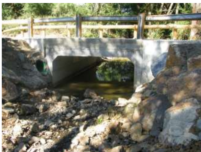
Figure 49 : exemple de mise en place d'un pont-cadre
