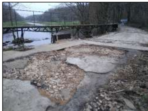
Figure 41 : route dégradée par la crue
