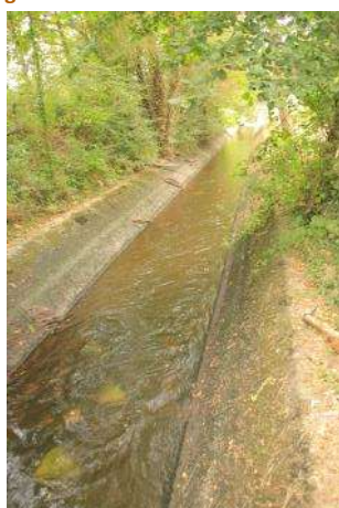
Figure 15: Canal bétonné sur la Tardoire
