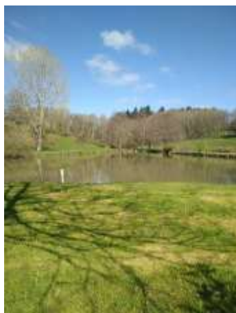
Figure 32: Barrage sur le Brisebois
